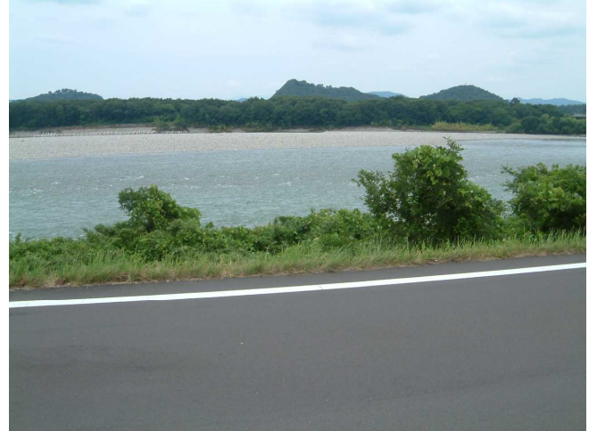
【松倉城跡沿いの木曾川堤防】
